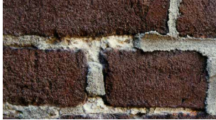
AFB. 4.6 Diverse typen van schades van linksboven tot rechtsonder: delaminatie van metselmortel en uitdrukken van de voeg; hechtingsverlies voeg - baksteen met gelijktijdige vervorming van voeg; uitdrukken van de voeg; verzanding van de voeg (MDCS).
