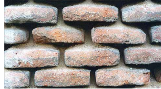
AFB. 4.6 Diverse typen van schades van linksboven tot rechtsonder: delaminatie van metselmortel en uitdrukken van de voeg; hechtingsverlies voeg - baksteen met gelijktijdige vervorming van voeg; uitdrukken van de voeg; verzanding van de voeg (MDCS).
