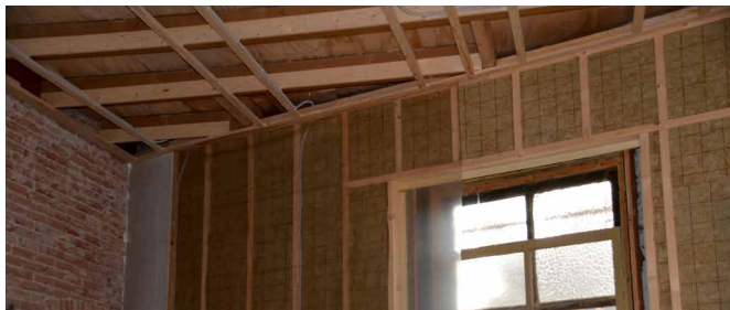
AFB. 7.7 Binnenisolatie wordt aangebracht bij een historische woning op het landgoed Sevenaer. In dit geval in de vorm van een houten stijl- en regelwerk met minerale wol op een korte afstand van de massieve bakstenen buitenmuur (steens dik). Over de dampremmende folie wordt de wand afgewerkt met een gipsplaat (Wido Quist).
