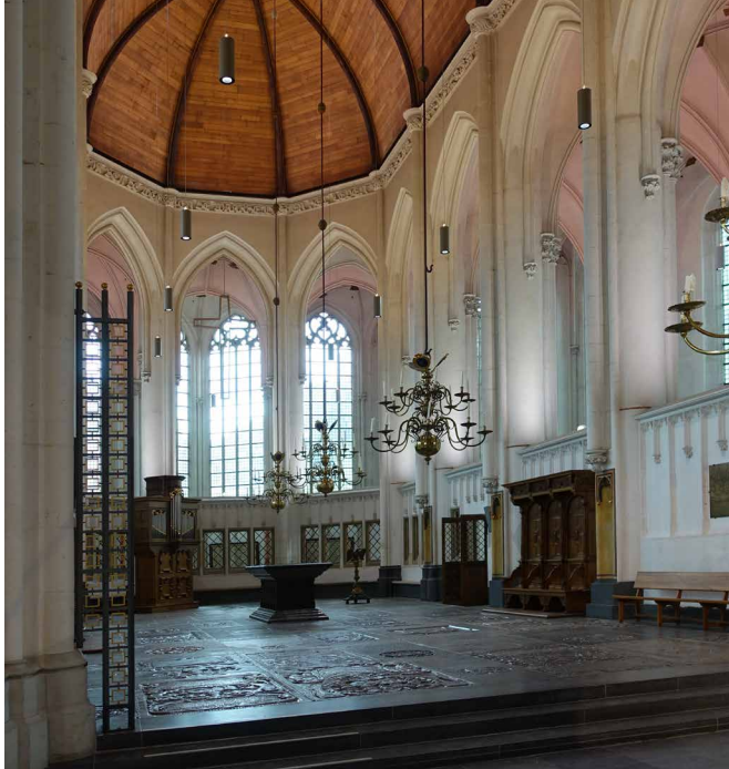
AFB. 1.8 Stevenskerk Nijmegen waar vanuit het KaDER-project de financiële aspecten zijn geanalyseerd maar ook concreet is meegedacht over het plaatsen van voorzetglas bij de glas in loodramen en het wel of niet isoleren van de stenen gewelven (Hielkje Zijlstra).
