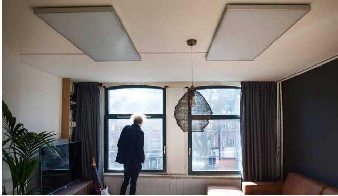
AFB. 8.10 Infraroodpanelen in een grachtenpand (OneWorld).
