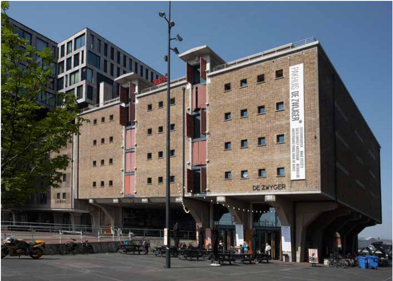
FIG. 3.42 De Zwijger, Amsterdam. Architectenbureau J. van Stigt, 2006. [FIG. 3.42–3.43]
