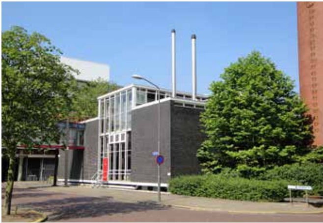
FIG. 3.55 Ketelhuis Ceres, TU Eindhoven (before intervention). S.J. van Embden (OD205), 1959, extension 1967. [FIG. 3.56–3.57]
